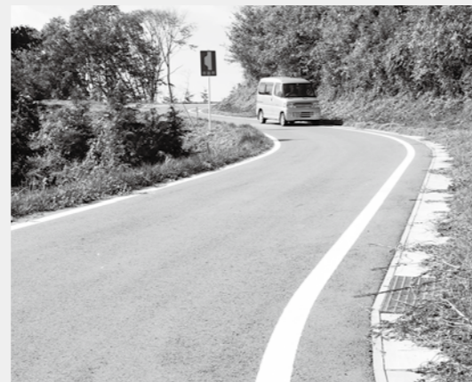
整備された村内の道路
