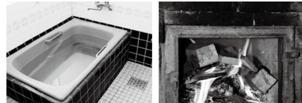
1_3回に分けてまきをくべ、湯を沸かす。冬場は午後4時ごろから沸かし始める 2_たき付けには廃材を使い、後で生木を加える。 3_ほんのり温かい足元のタイルは熱が伝わりやすい
