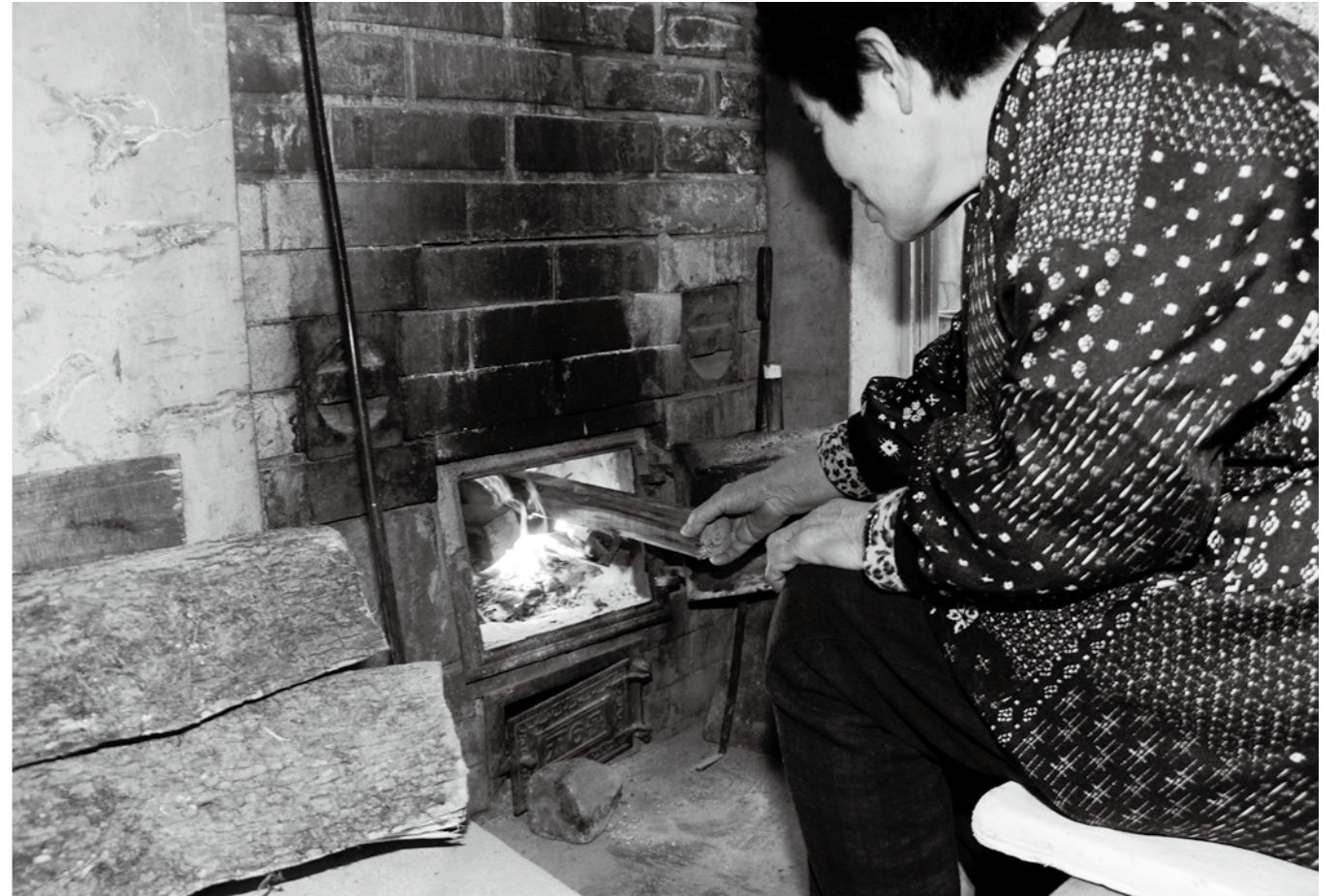
1_3回に分けてまきをくべ、湯を沸かす。冬場は午後4時ごろから沸かし始める 2_たき付けには廃材を使い、後で生木を加える。 3_ほんのり温かい足元のタイルは熱が伝わりやすい
