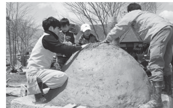
ピザ窯の修復作業をする参加者
