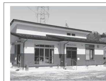
完成した岩野草コミュニティセンター
