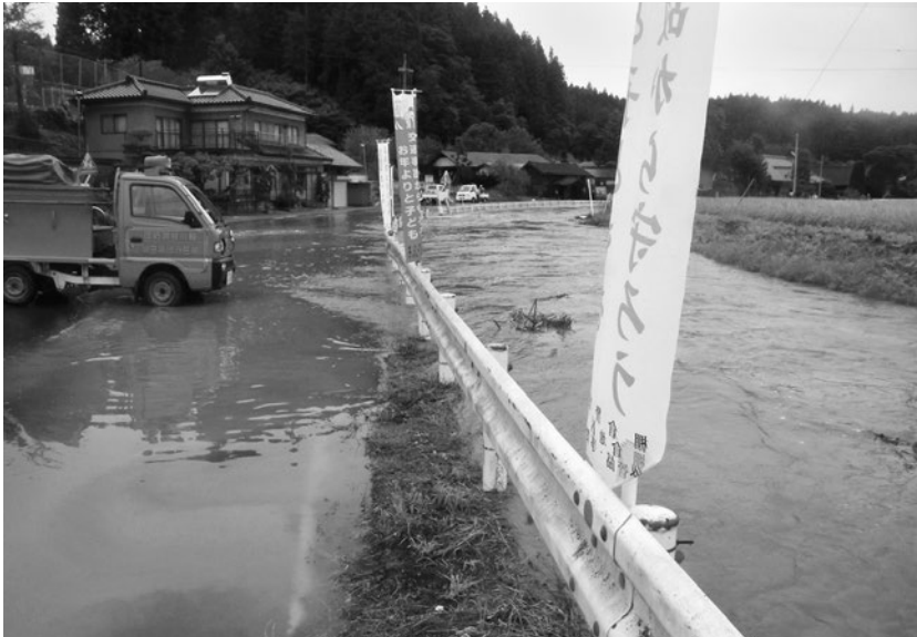
想定外の豪雨による浸水状況
