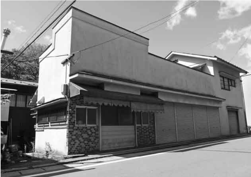
空き家の対策として改修が予定されている家屋
