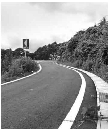
改良工事が全線完了した 村道遠ヶ竜戸草線(戸草地内)
