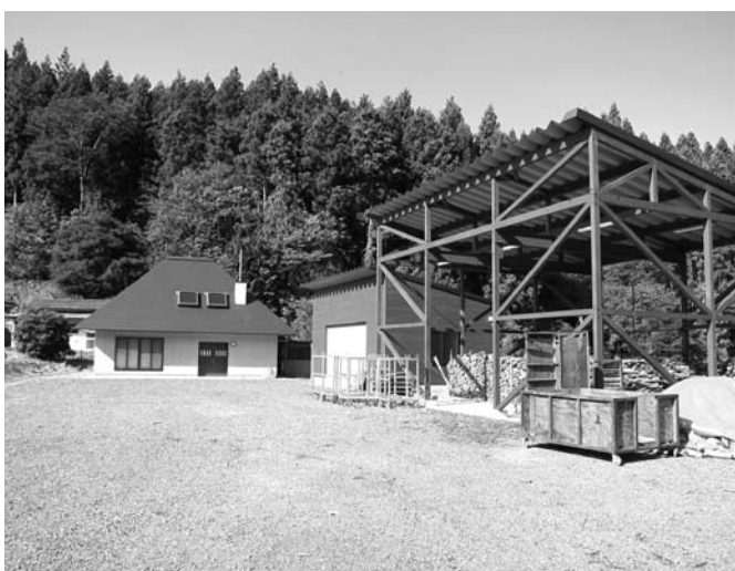
建築された大学連携試験研究施設と 薪ステーション(右側)～富田字八斗時地内～
