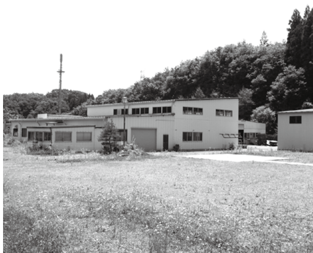
競売により取得した工場用地・建物(見渡地内)
