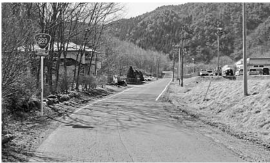
県よりバイパス案が示されている国道289号
