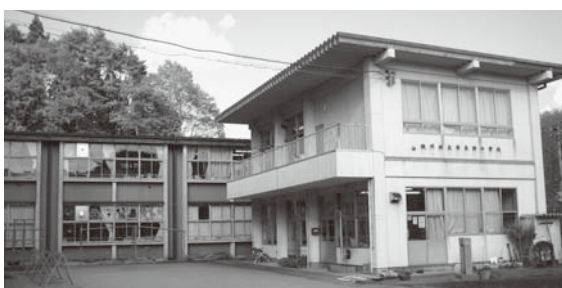
耐震補強改修工事が行われる青生野小学校校舎
