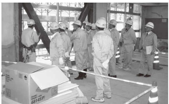
補強材が施行された状況（職員室）
