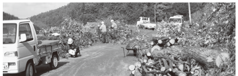
道路支障木伐採。シルバー人材センターへ委託
