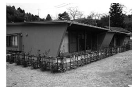
水口定住促進住宅
