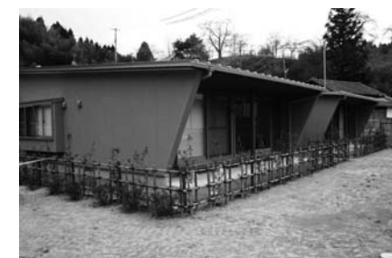
水口定住促進住宅
