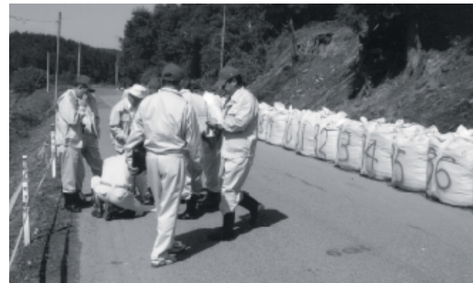
家屋が国道に流出した青生野地内現地 (次頁に続く)
