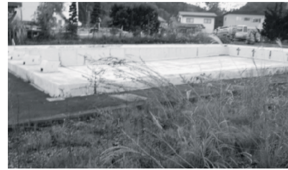
解体撤去される鮫川中学校プール
