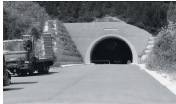
完成が待たれる国道289号線(いわき市・荷路夫バイパス)
