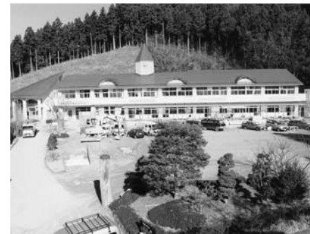
工事が進む「さめがわこどもセンター」
